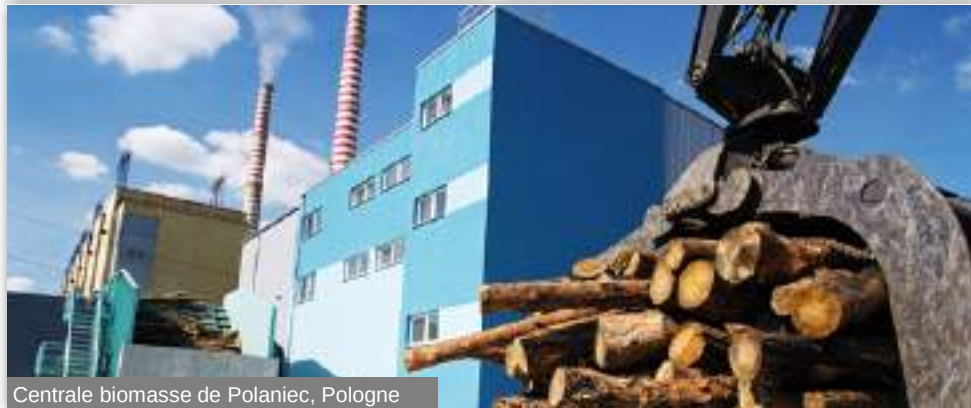
Centrale biomasse de Polaniec, Pologne
