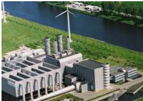
Centrale d'Herdersbrug, Belgique
