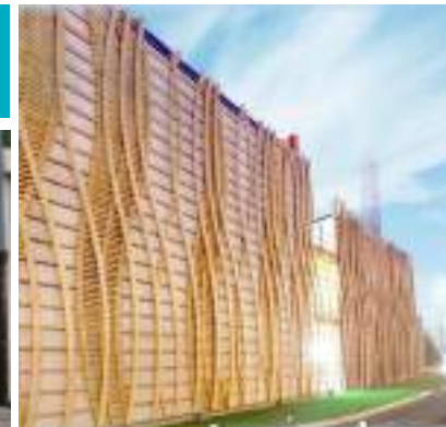
Chaufferie biomasse, France Concours photo interne
