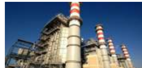
Centrale de Umm Al Nar, Abu Dhabi
