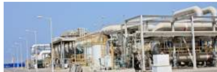
Centrale de Sohar, Oman
