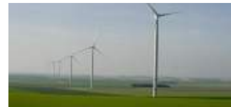
Parc éolien de Germinon France
