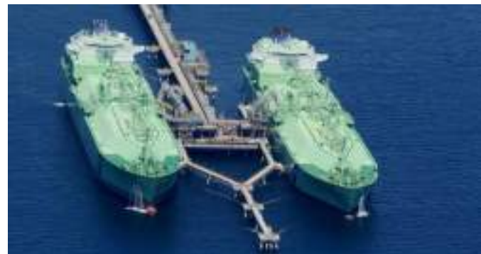
Terminal méthanier de Mejillones, Chili
