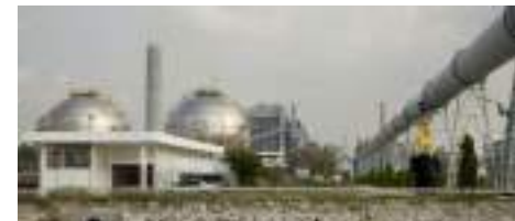
Centrale électrique, Thaïlande
