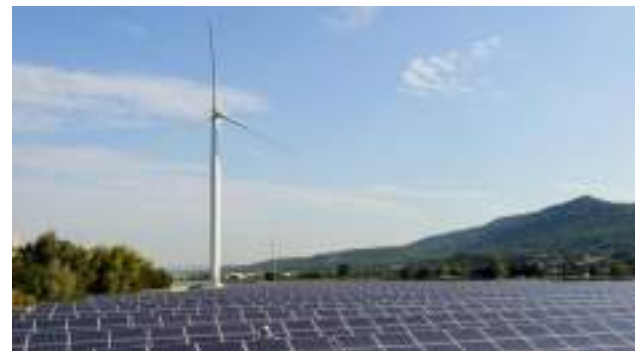
Parc photovoltaïque Bollène, France
