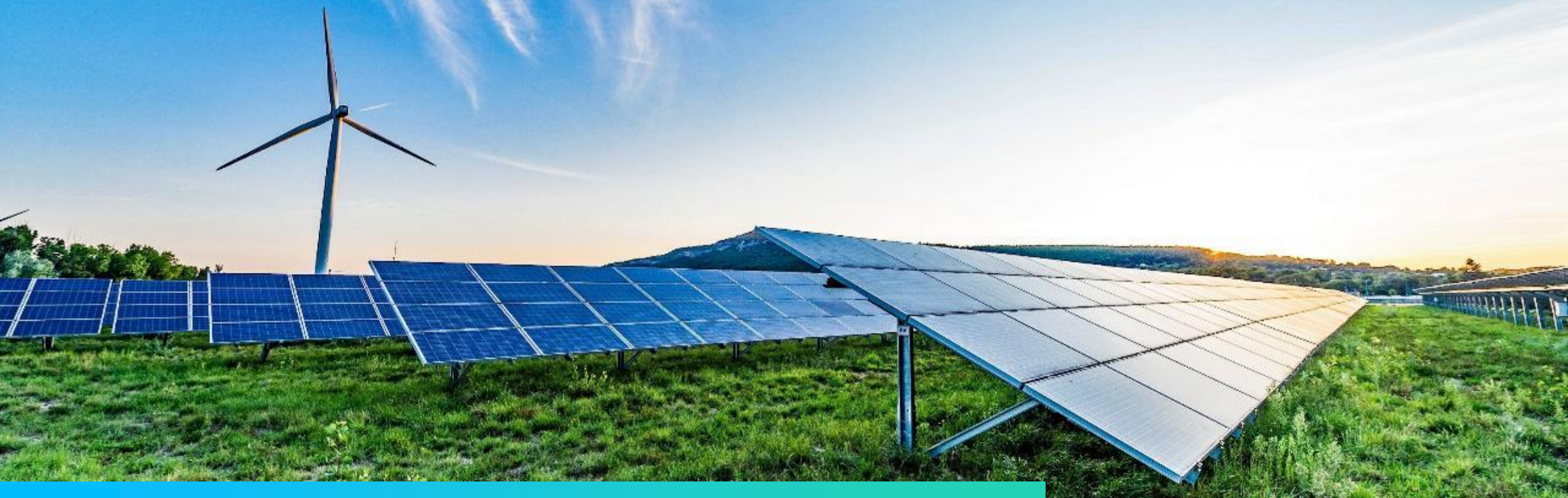
Parc photovoltaïque de Bollène 84
