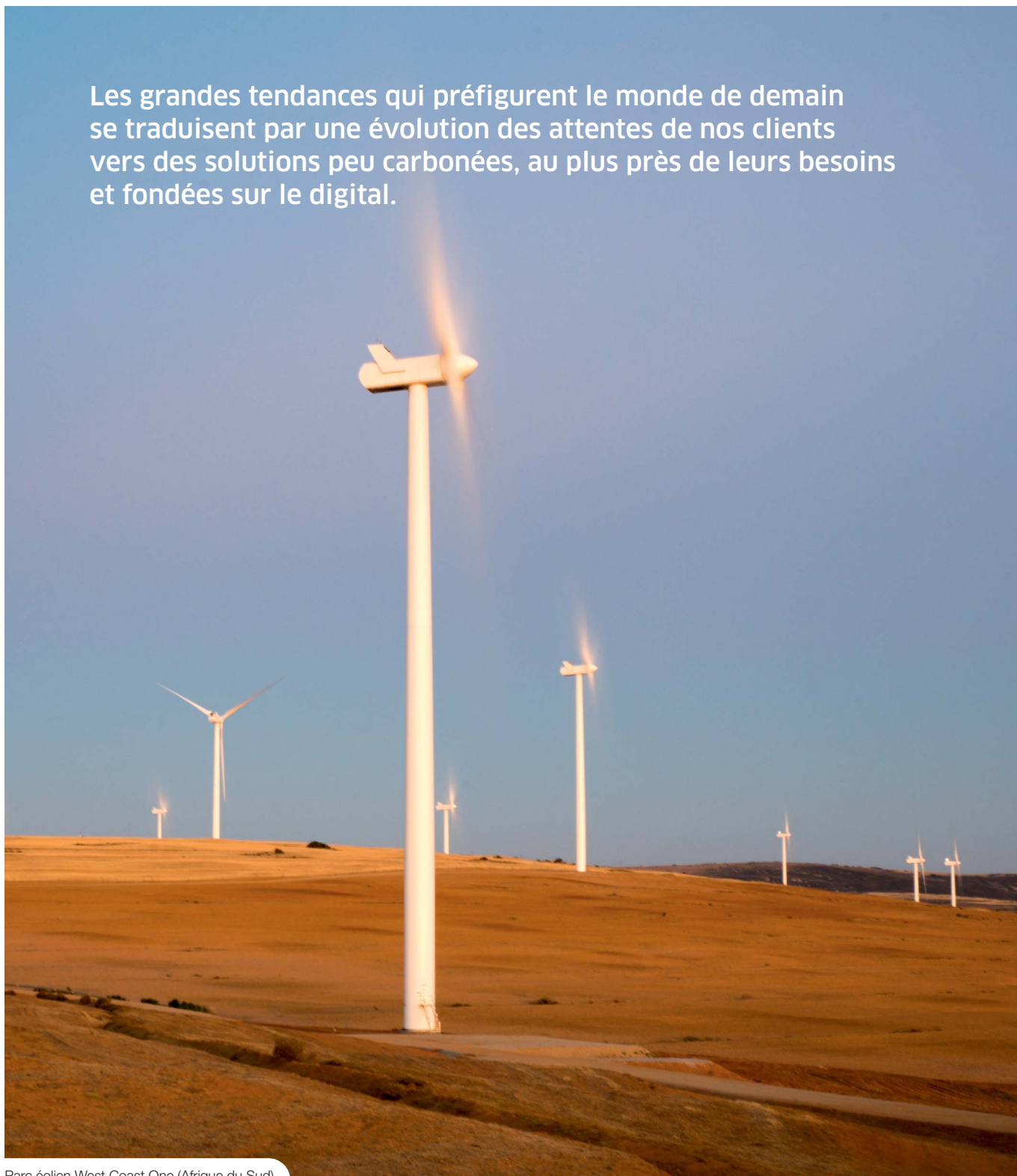
Parc éolien West Coast One (Afrique du Sud)
