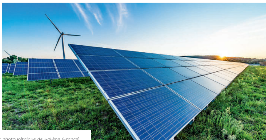
Parc photovoltaïque de Bollène (France)
