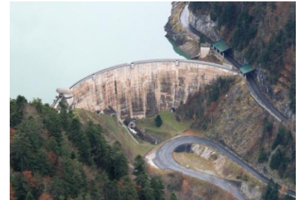
Fabrège Lake Dam , France
