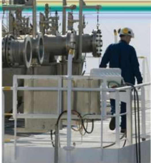
Provalys LNG tanker, Montoir, France
