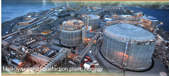
LNG terminal, Montoir-de-Bretagne, France
