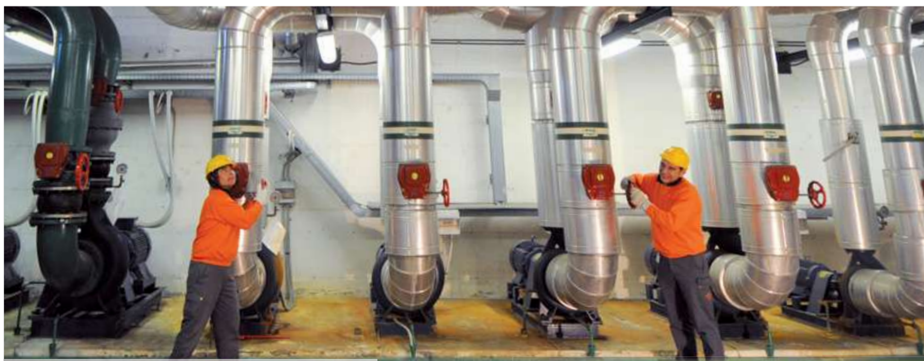
Maintenance d'une chaudière par des collaborateurs de Cofely.
