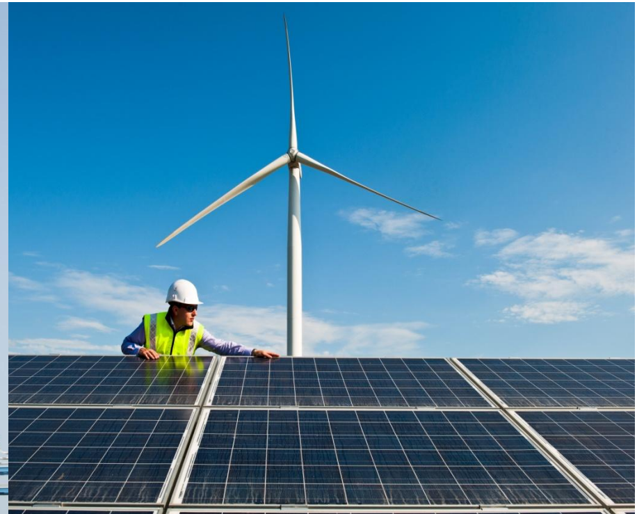
Parc photovoltaïque de Bollène, France
