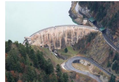
Fabrège Lake Dam, France
