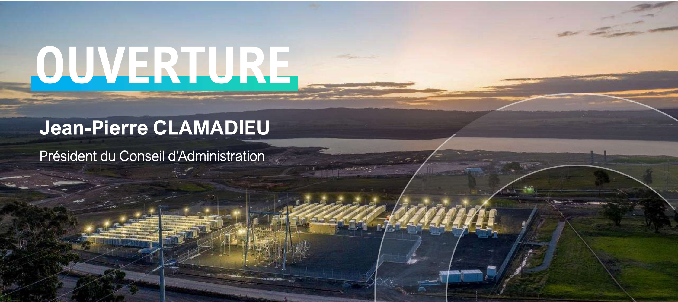
Système de stockage d'énergie par batterie d'Hazelwood - Australie
